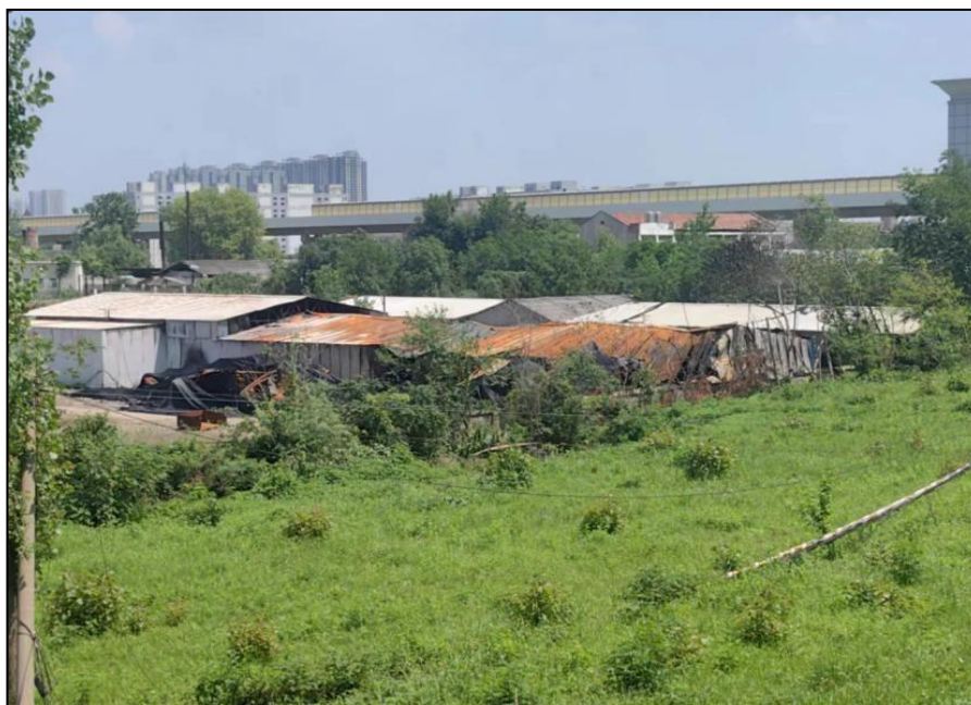
图1 事故建筑外观图
