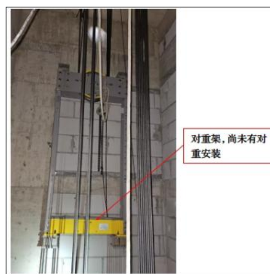
图 10 已安装的轿厢对重架
