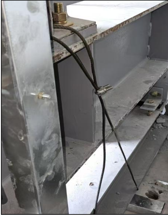
图 19 东侧固定在工字钢上的钢丝绳 图 20 东侧用绳夹连接的钢丝绳
