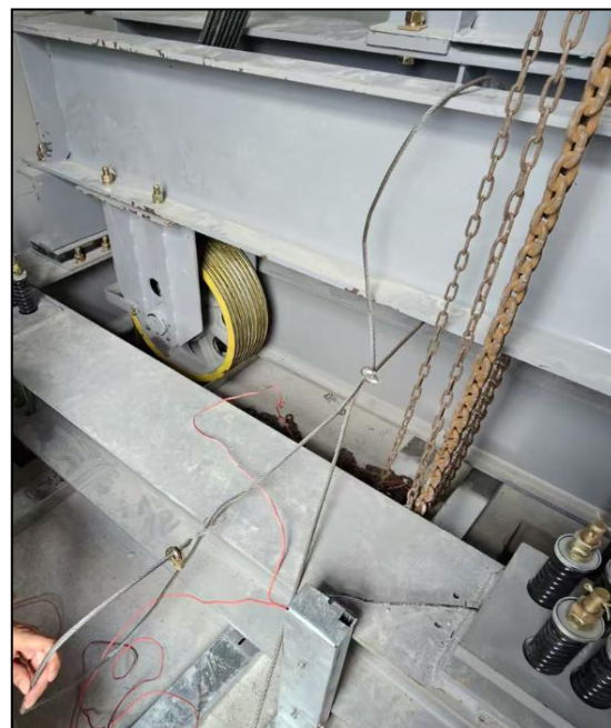
图 18 西侧固定在工字钢上的钢丝绳
