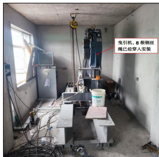
图 8 顶层电梯机房现状
