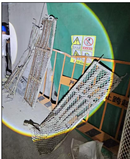
图 11 底坑清理出的 3 块钢制脚手板
