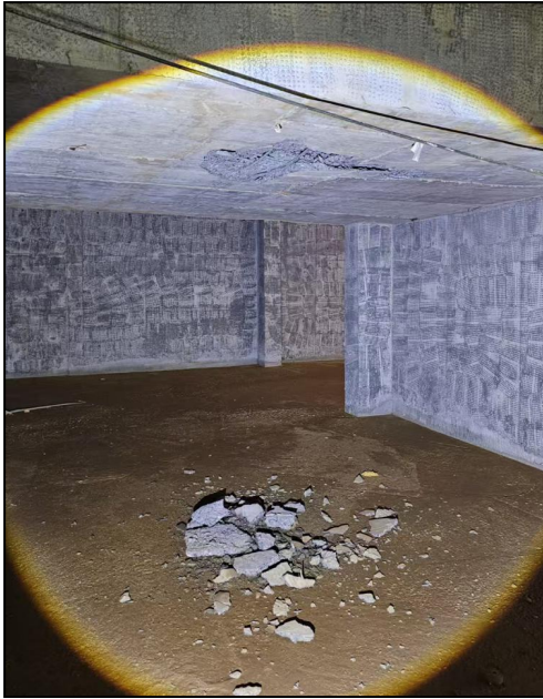
图 13 底坑下部夹层顶板破坏情况
